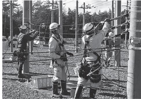
(株)相双電力センター配電工事課様のご指導・ご協力のもと、座学では作業安全、緊急時の連絡体制、無停電張替工事についての講義が行われました。実技では昇降柱訓練、100mm引込線新設撤去工事、引込線無停電張替、中間支持施工の訓練を実施しました。
